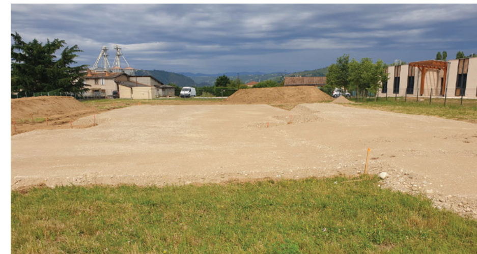
Début du chantier du Pôle Associatif
