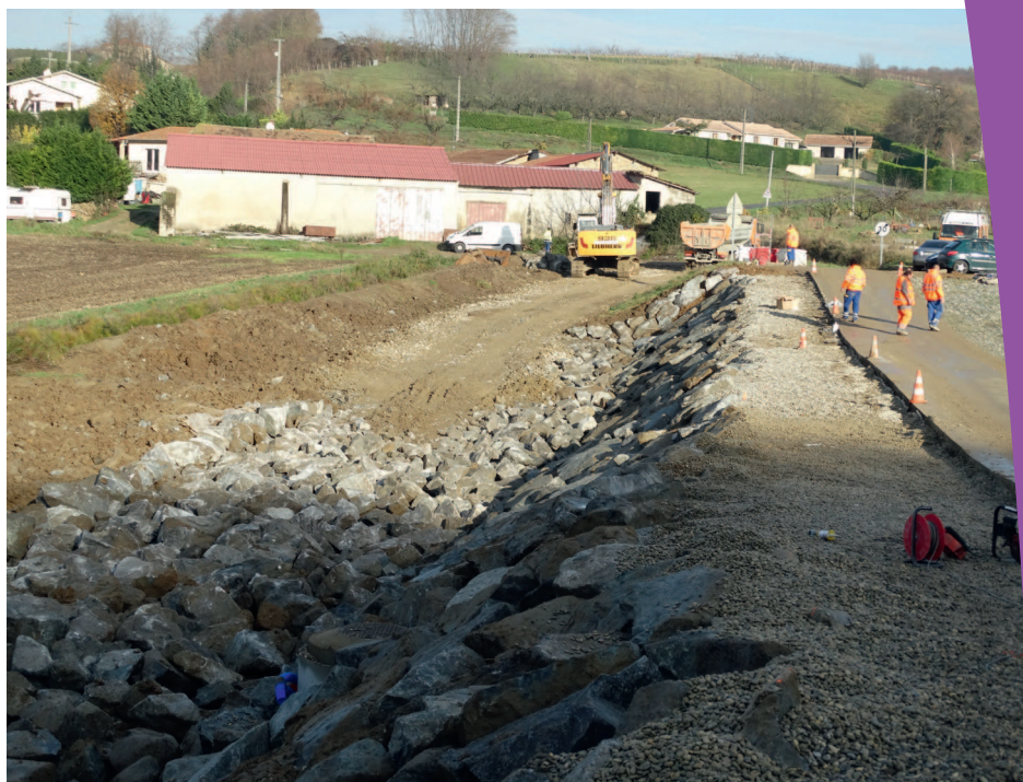
Ci-dessus : travaux du bassin écrêteur
