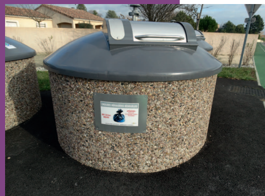
Ci-dessous : containers semi-enterrés
