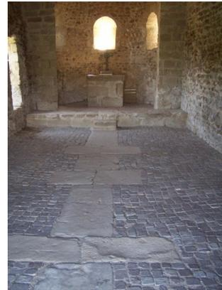
Il est alors décidé de récupérer les pavés enlevés place de la mairie, et un à un, ils sont nettoyés du béton accroché et posés pour réaliser la finition du sol.
